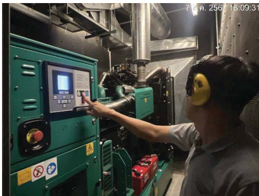
ดูแลและตรวจสอบระบบไฟฟ้าสำรอง
